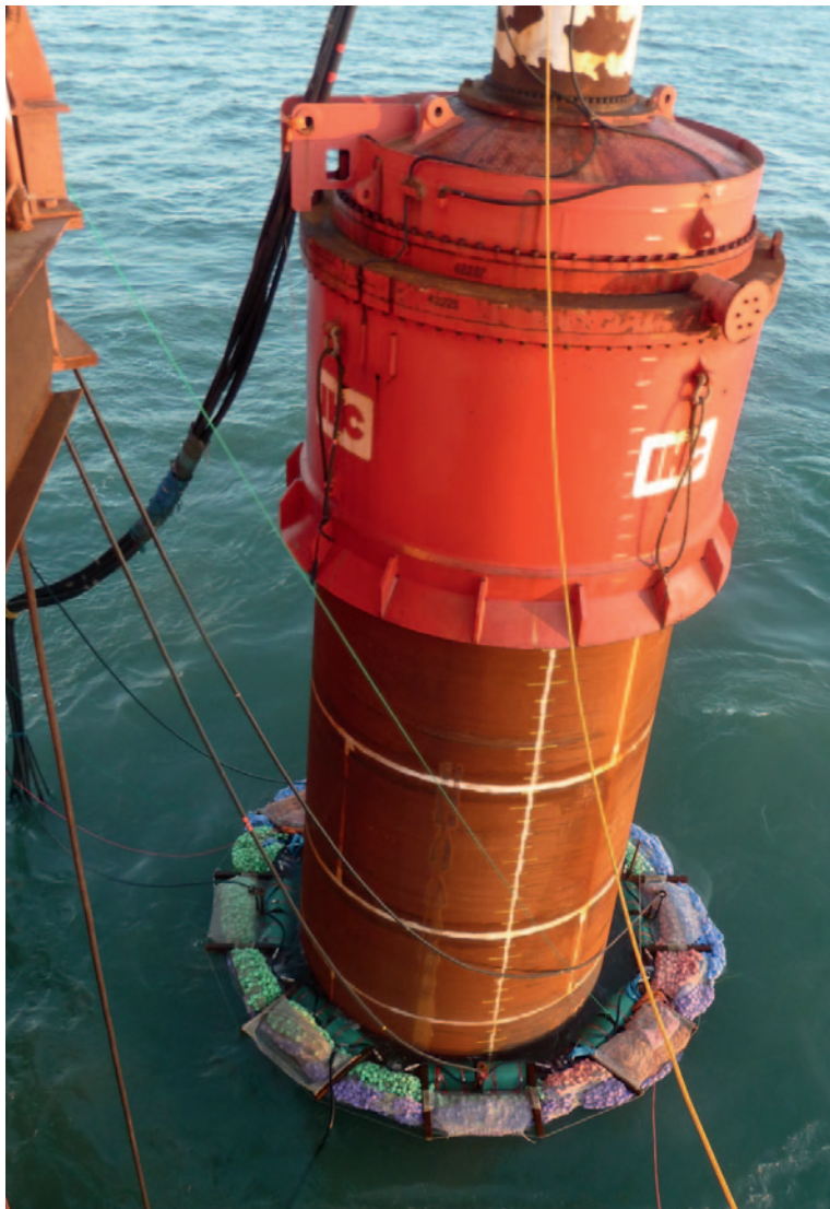
Hydroschalldämpfer im Einsatz beim Bau des Offshore-Windparks London Array.
