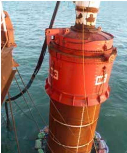
Hydroschalldämpfer im Einsatz beim Bau des Offshore-Windparks London Array.
