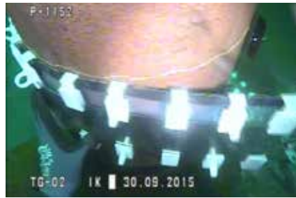
Abbildung 19: Taucherarbeiten in 18 m Tiefe am Rohrknoten im Offshore-Windpark Baltic 1
