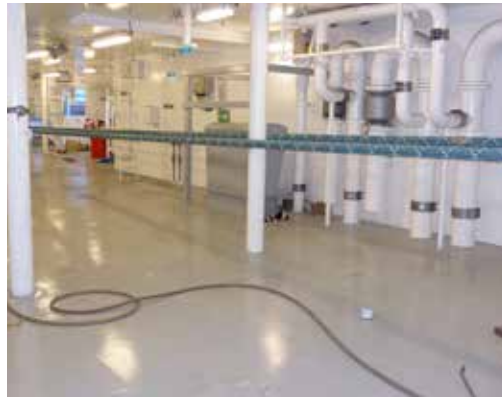
Abbildung 4: Installation der drahtlosen Sensorknoten auf dem Windendeck des Demonstrators. Die Positionen zweier Sensorknoten sind rot markiert
