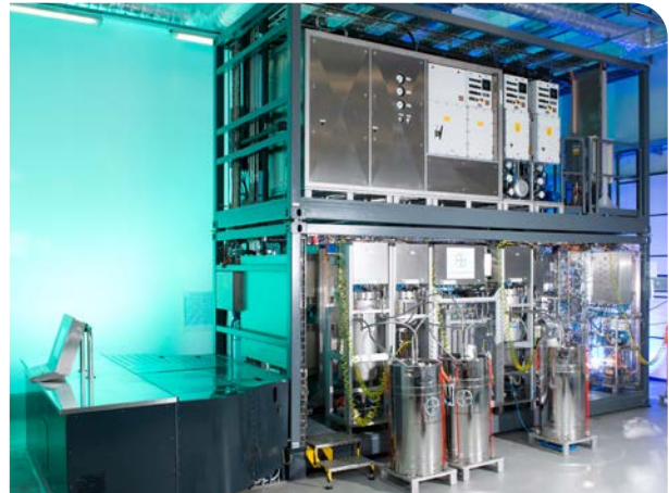
Modulare Anlage für eine flexible, schnelle und effiziente chemische Prozessindustrie
