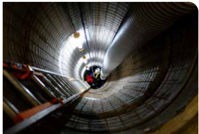
Installation der Instrumentierung in Sandwich-HP-Experimentalschacht
