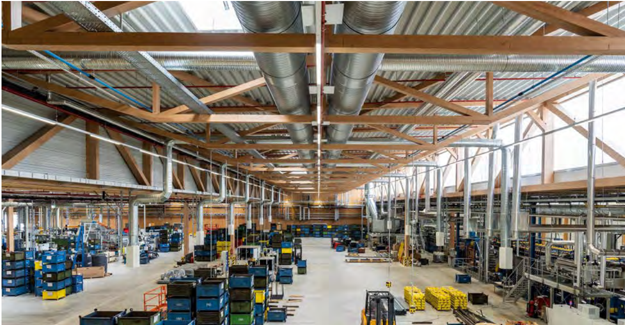
Das Dachtragwerk im Schraubenwerk von SWG in Gaisbach wurde aus dem Holzwerkstoff Baubuche konstruiert.
